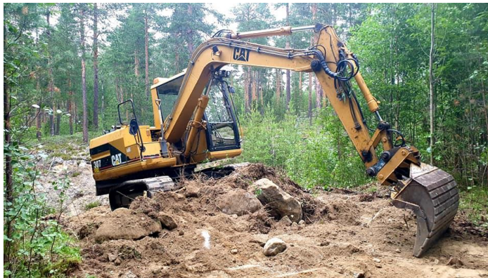
Nergrävning av trumma samt bygge av väg mellan 2 hål över dike
